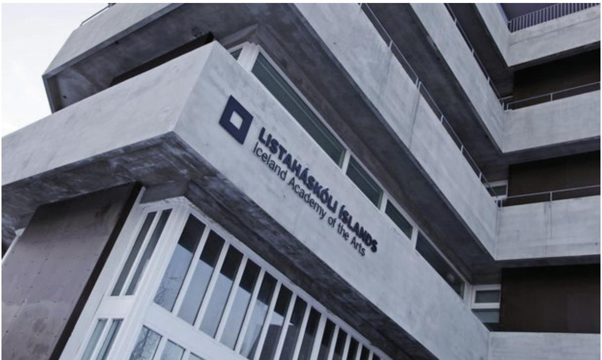
Mynd 1. Aðalskrifstofur skólans og hönnunar- og arkitektúrdeild eru til húsa að Þverholti 11 í Reykjavík. Nýir eigendur, FI-fasteignir, tóku við fasteigninni veturinn 2013-2014 og endurnýjuðu leigusamning við skólann til 10 ára með útgönguleið eftir 5 ár. Um leið var 6. hæðin opnuð á mill hólfa og nýttist hún nú mun betur en áður.
